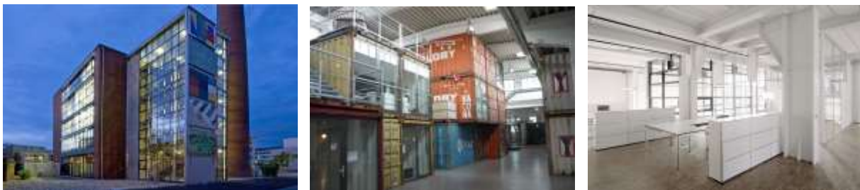
Abb. 02 Umbau PFAFF-Werk in Karlsruhe-Durlach u. a. Kalte Halle mit Bürocontainern / © RaumFabrik-Durlach.de
